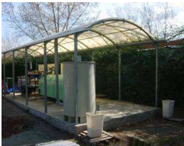
Le toit du composteur mécanique avant l'installation
