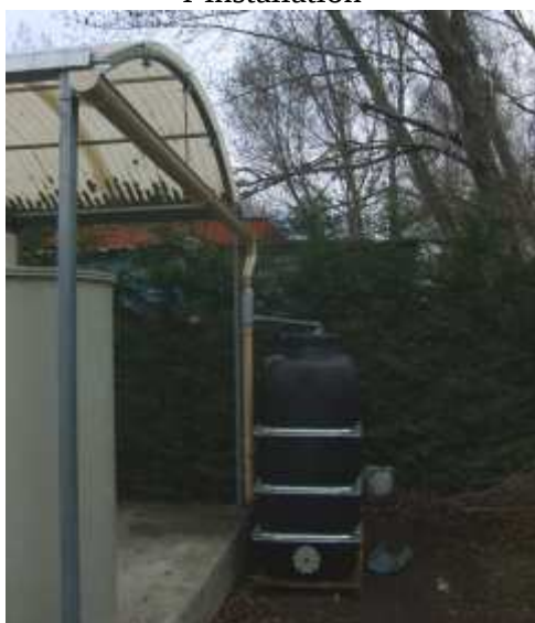
La cuve installée
